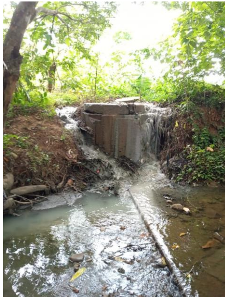
Figura 2. Manhole que vierte el agua residual de la PTAR al caño Las Pitas.
