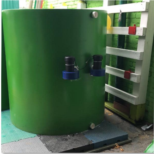
Figura 16. Tanque de enfriamiento
