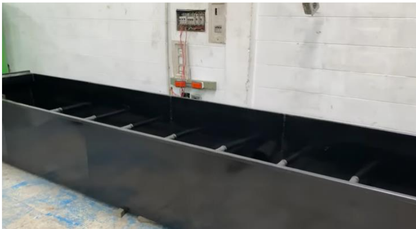
Figura 17. Torre de enfriamiento
