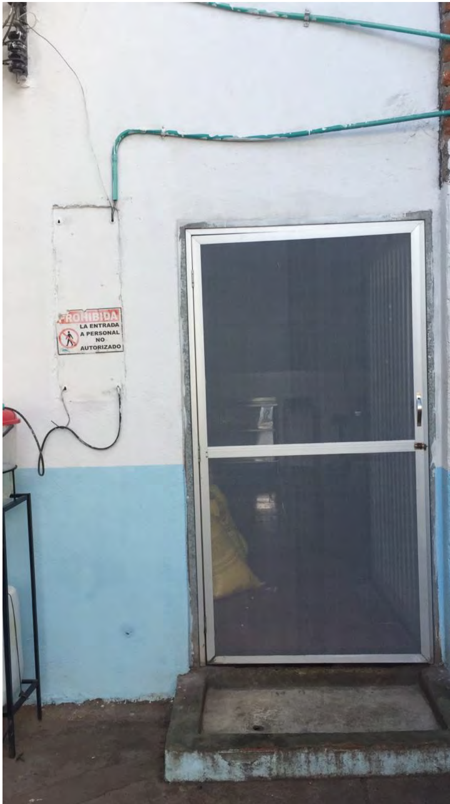
Figura 31. Zona de Acceso del Personal
