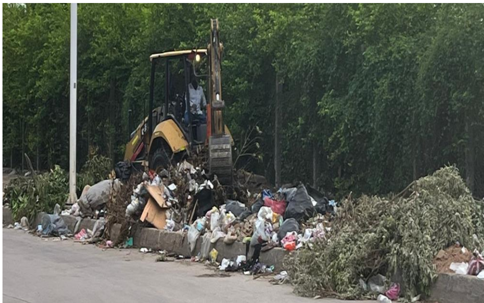
Figura 18. Limpiezas Por Excavadora a Residuos
