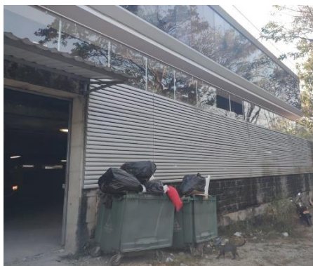
Contenedores para almacenamiento temporal de residuos.
