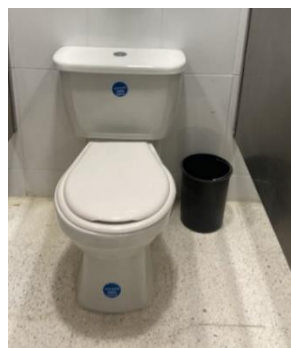
Sanitario de baños para damas.
