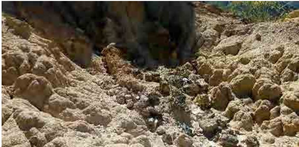
Figura 20. Punto crítico en espacios de socavones.
