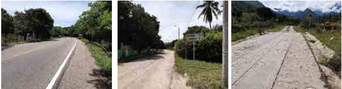
Figura 9. Estado de la vía de acceso Valledupar – Río Seco - Patillal y Atánquez – Chemesquemena (de izquierda a derecha).
