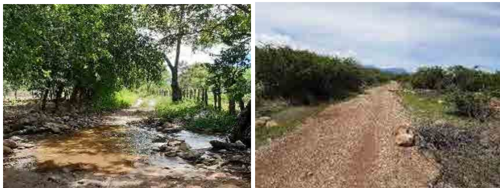
Figura 8. Estado de la Vía de Acceso Río Seco – Murillo, Río Seco – Río Seco. - La Mina (de izquierda a derecha).
