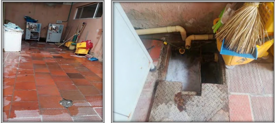
Figura 7.18 Evidencias de inspección del sistema de desagüe de aguas de lavado de la E.S.E
