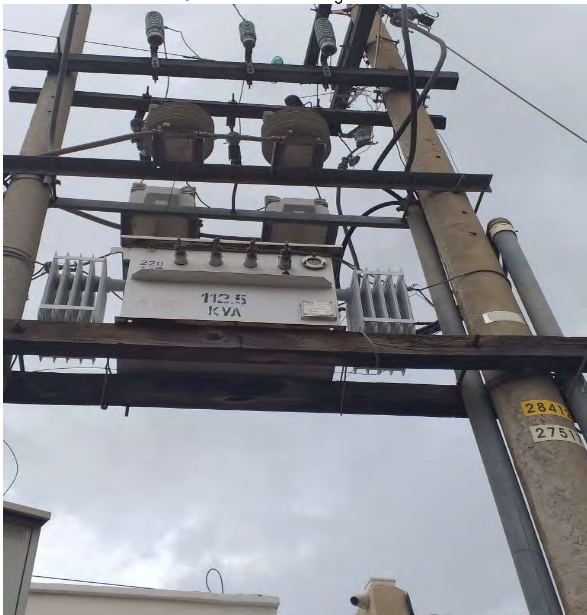
Anexo 28. Foto de estado de generador eléctrico
