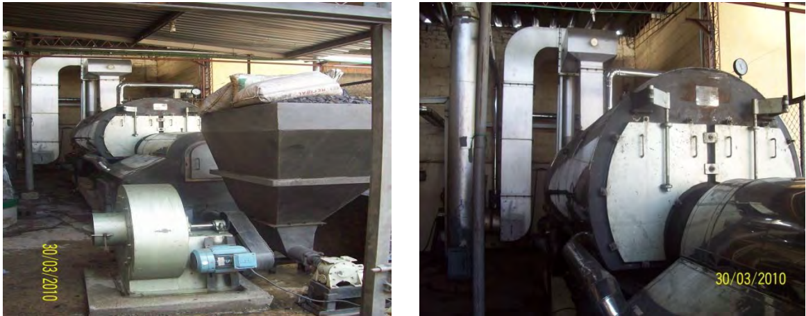
Figura 7. Sistema de caldera a carbón lácteos primavera
