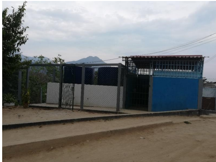
Figura 10. Sistema de tratamiento de Agua para consumo de Atánquez. Fuente. Autor, 2019
