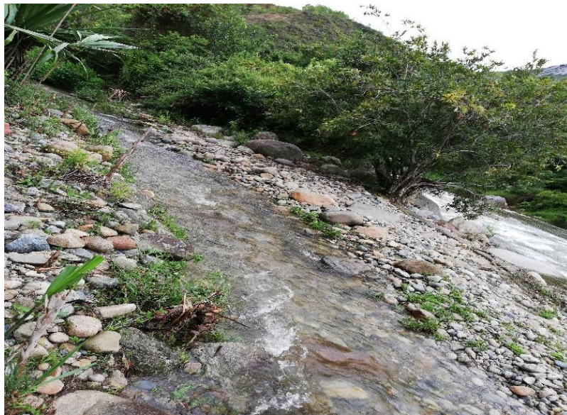
Figura 6. Canal de derivación.
