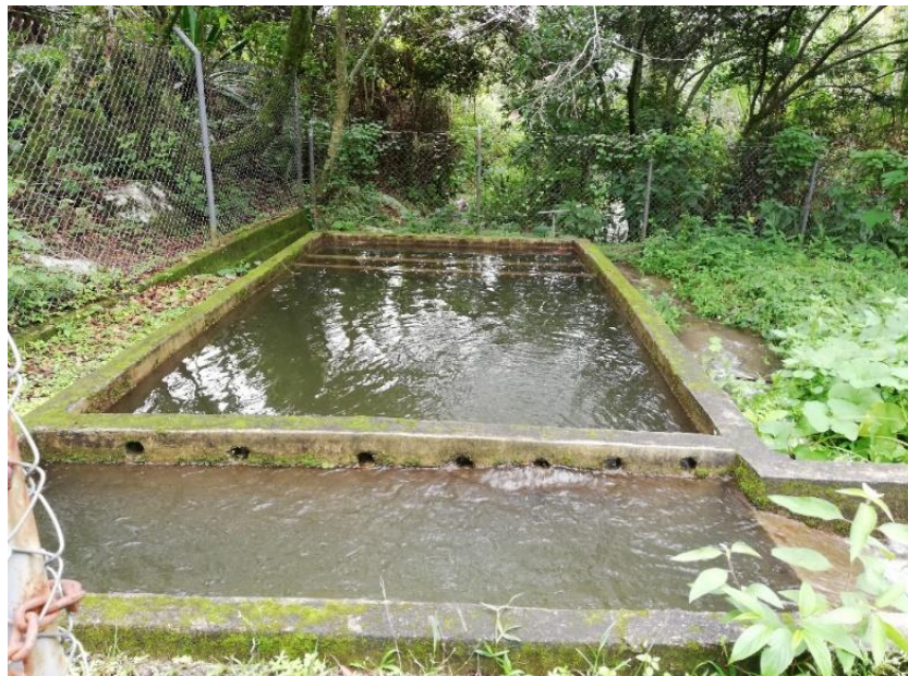
Figura 8. Desarenador. Fuente. Autor, 2019.
