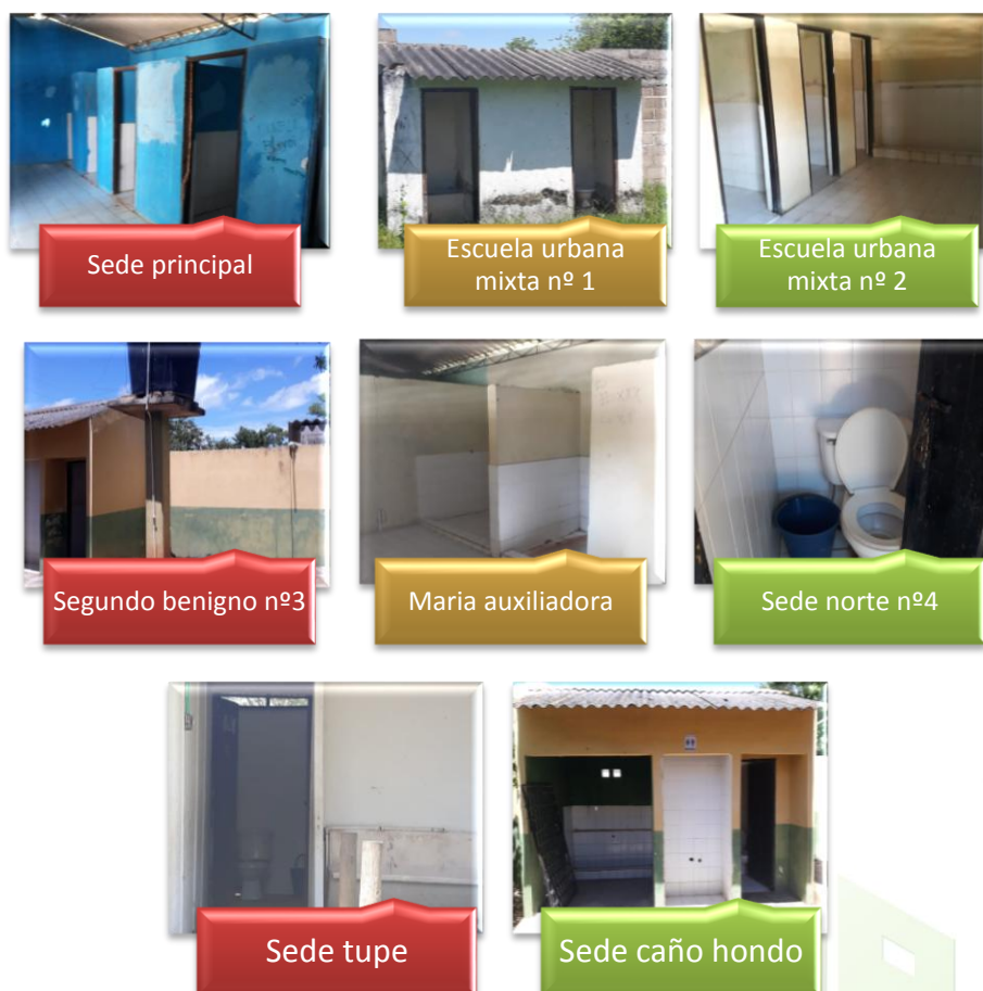
Imagen 12. Áreas de Baños y aseo en la institución “CODELMIX”.
