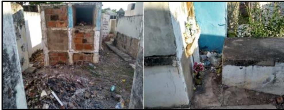
Fotografía 4: Estado de material de las Bóvedas
