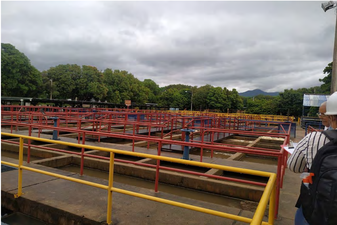
Figura 15 Planta de Tratamiento de Agua Potable-PTAP
