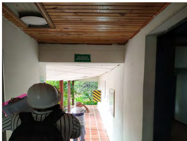
Figura 18 Infraestructura Planta de Tratamiento de Agua Potable-PTAP
