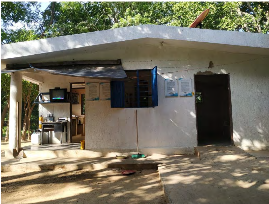
Figura 25 Infraestructura Planta de Tratamiento de Aguas Residuales – PTAR
