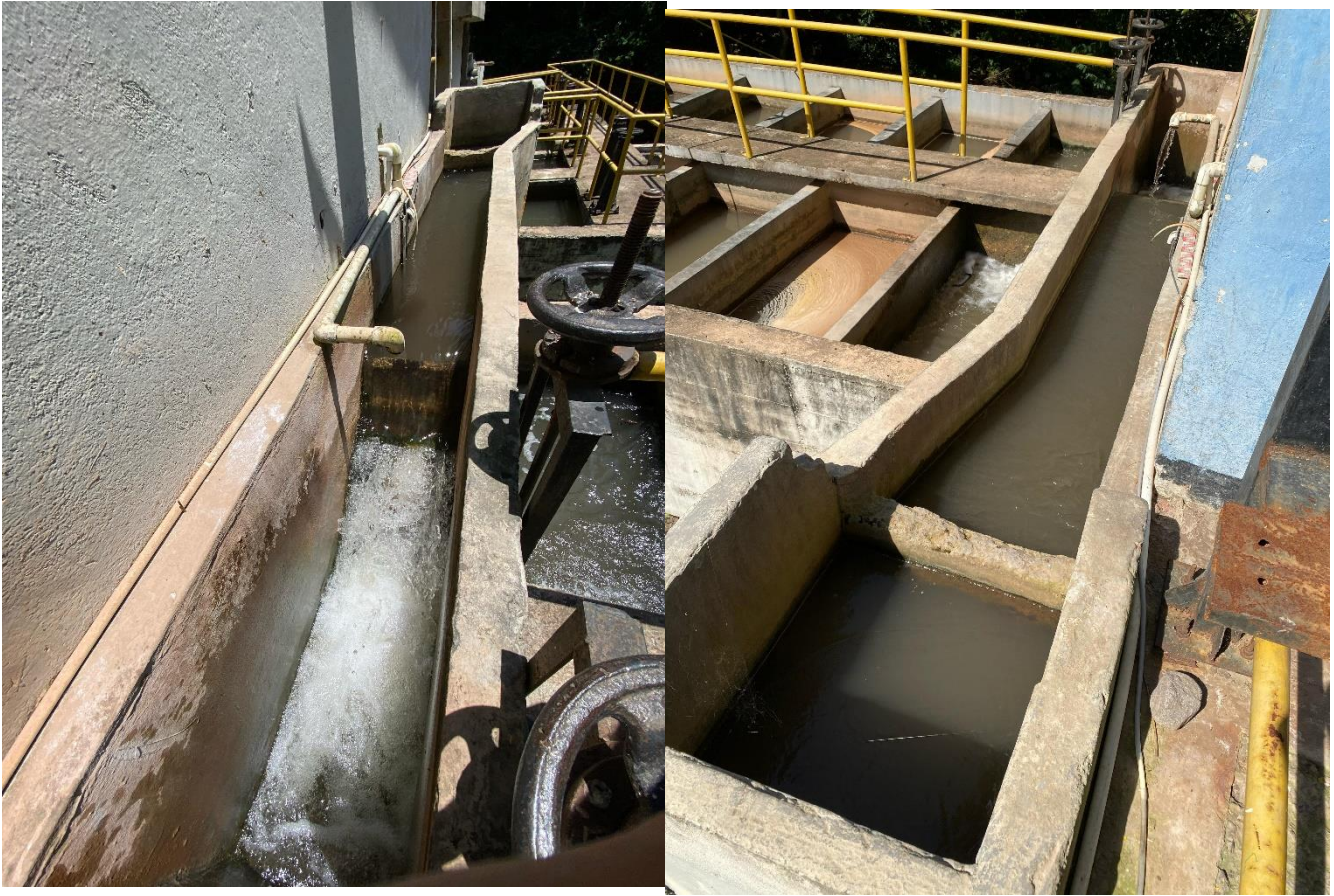
Figura 11. vertedero tipo perfil Creager.
