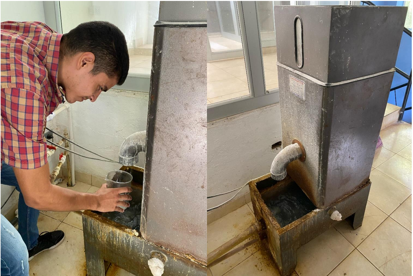
Figura 14. Dosificador de sulfato de aluminio en seco, volumétrico tipo tornillo sin fin.
