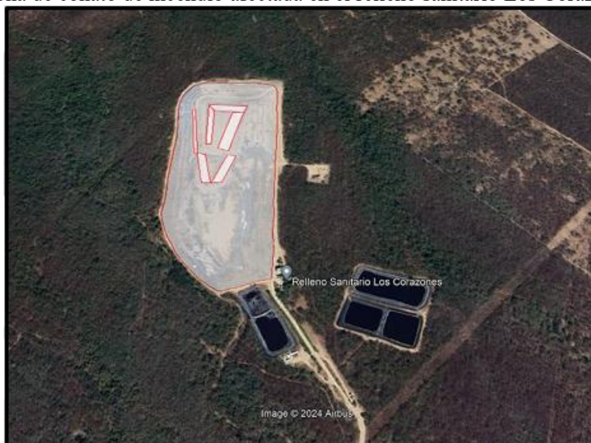
Figura 9. Zona de conato de incendio afectada en el relleno sanitario Los Corazones.
