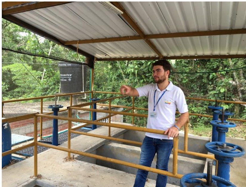
Foto 1 Revisiones previas Planta de tratamiento de agua potable El Castillo- Meta
