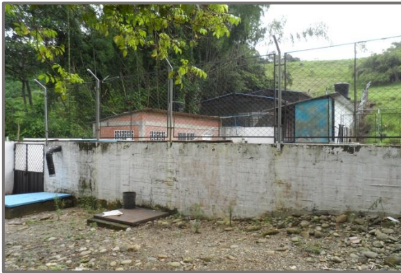
Ilustración 11 planta de tratamiento de agua potable PTAP El Castillo vista desde afuera
