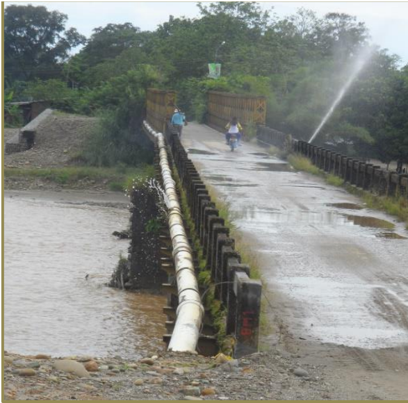
Ilustración 16 línea de conducción 8"
