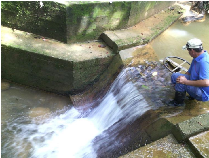
Foto 4 Captación Caño Antioquia
