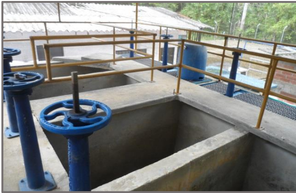
Ilustración 14 Filtros ascendentes vista lateral Fuente: Autores 2016.
