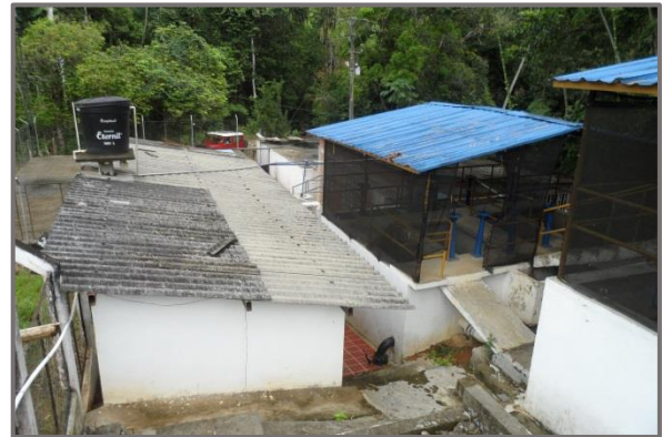
Ilustración 12 Planta de Tratamiento de Agua Potable PTAP El Castillo vista desde arriba
