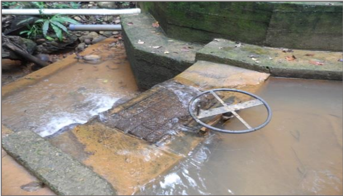
Ilustración 6 Bocatoma Caño Antioquia
