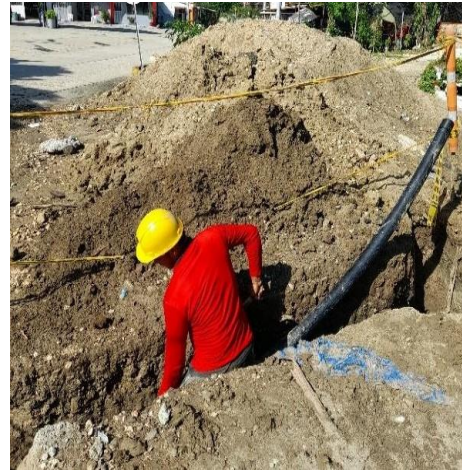
Figura No. 16 Relimpieza de excavación en tramo troncal zona lateral de caja macromedidor 3" ubicada en entrada principal.
