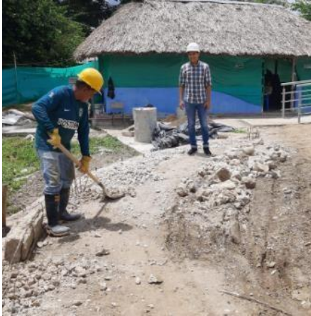
Figura No. 18 Recolección de escombros
