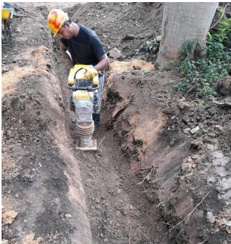
Figura No. 15. Compactación de relleno con material del sitio en tubería PEAD D=250 mm en tramo troncal sector entrada Villa Rosita..
