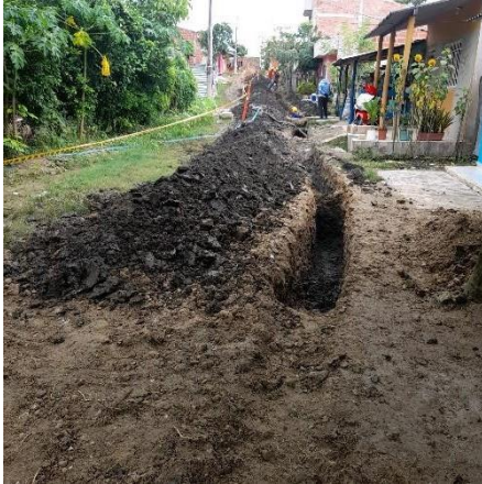
Figura No. 10. Excavación para instalación de tubería PEAD D=90 mm en callejón #2, sector las flores.
