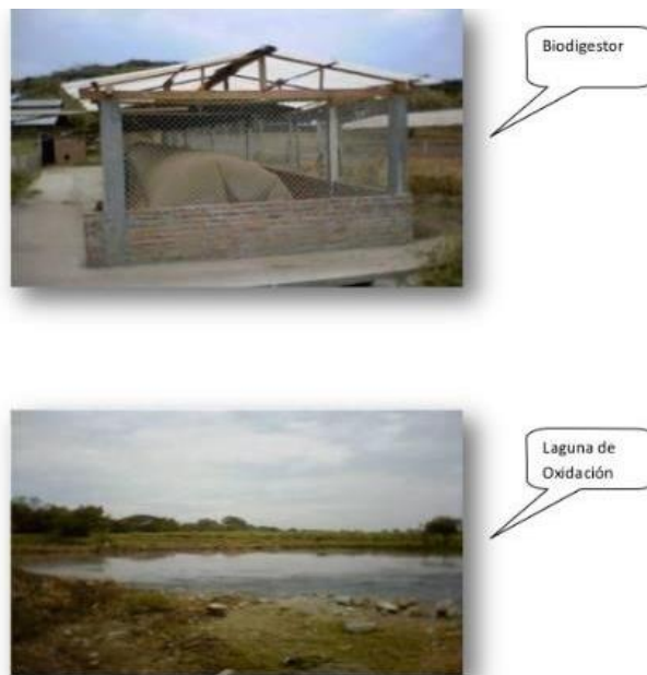
Figura 13. Biodigestor y laguna de oxidación
