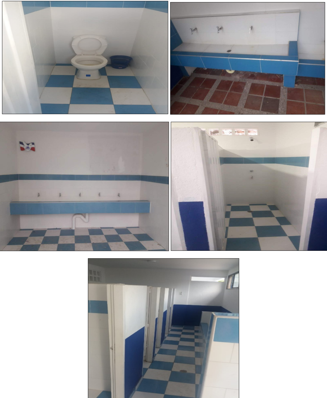
Figura 14. Adecuación en los baños por sistemas ahorradores
