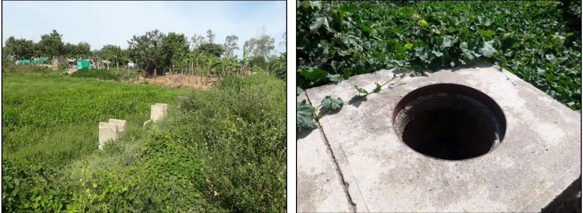
Fotografía 5. Secuencia fotográfica con las estructuras existentes
