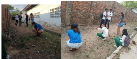
Figura 18: Marcación del terreno
