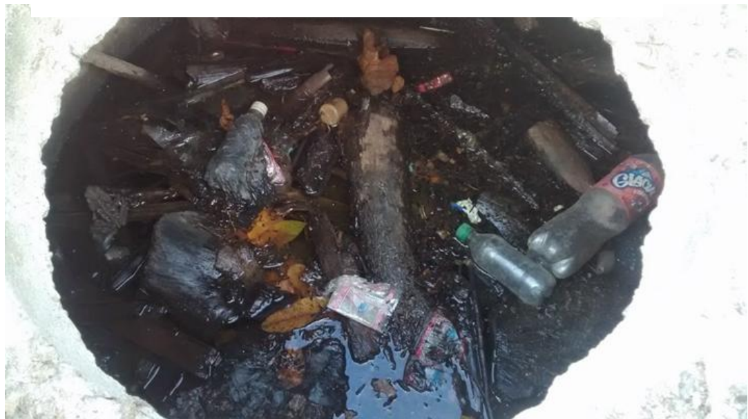
Foto 23. Pozo colmatado en el corregimiento de San Sebastián
