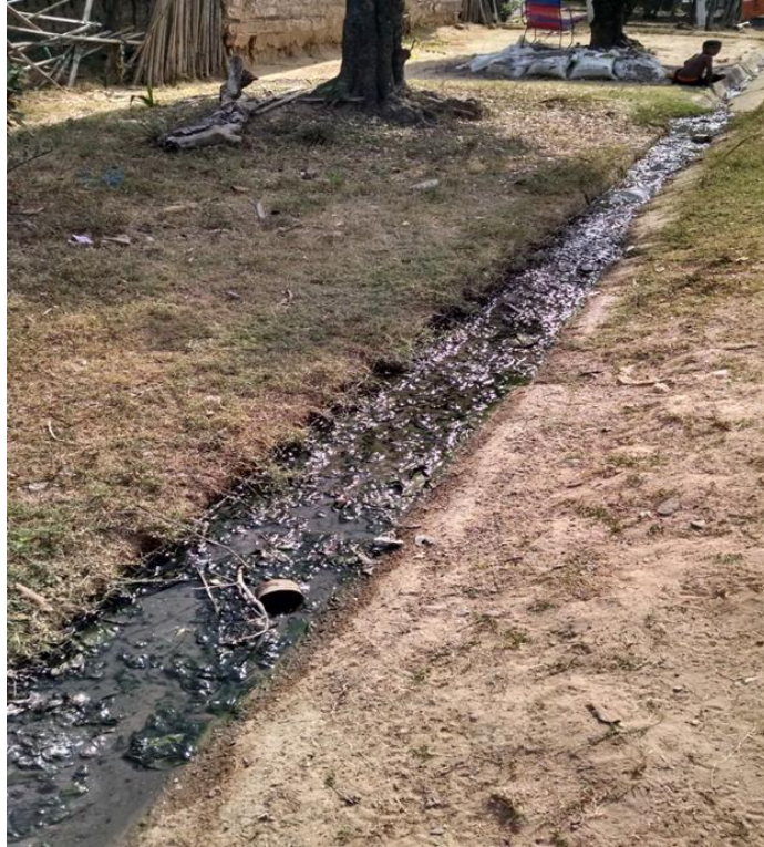
Foto 5. Canaletas en las calles del corregimiento de La Mata
