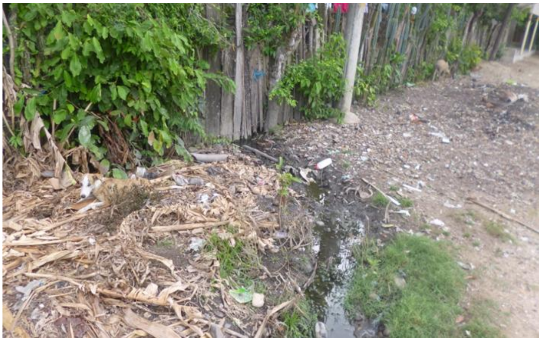
Foto 14. Vertimiento de aguas residuales a las calles de Puerto Boca
