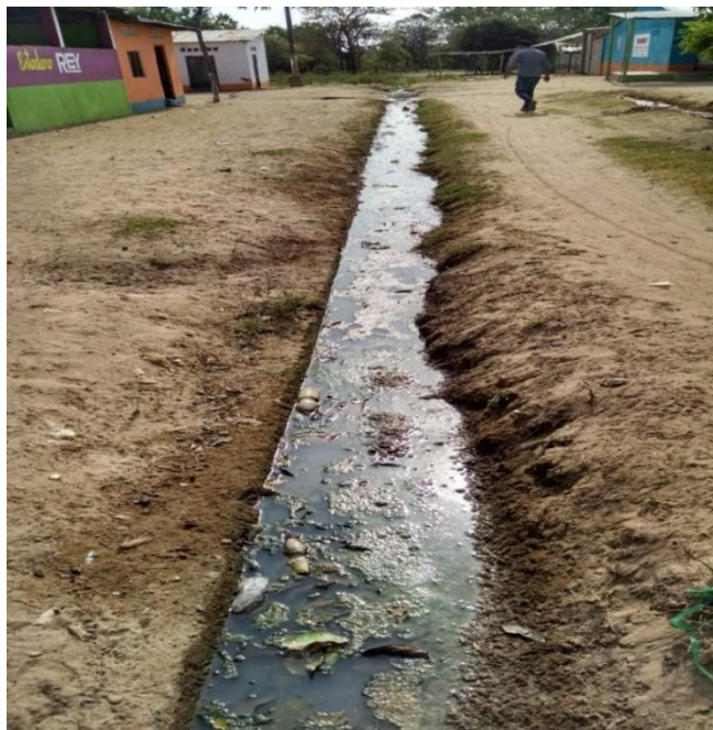
Foto 6. Canaletas artesanales recolectoras de Agua Residuales en el corregimiento de La Mata
