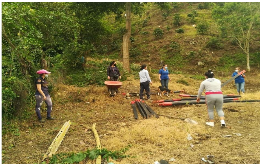
Figura 15: Acondicionamiento del terreno
