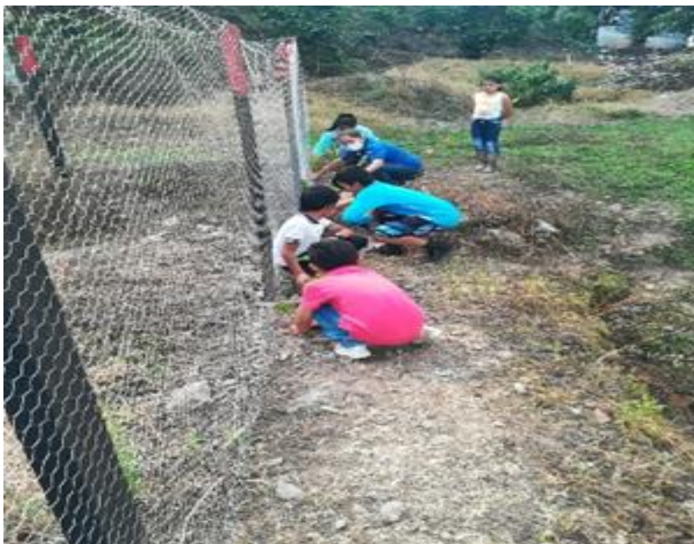
Figura 35: Construcción del encerramiento de la huerta casera
