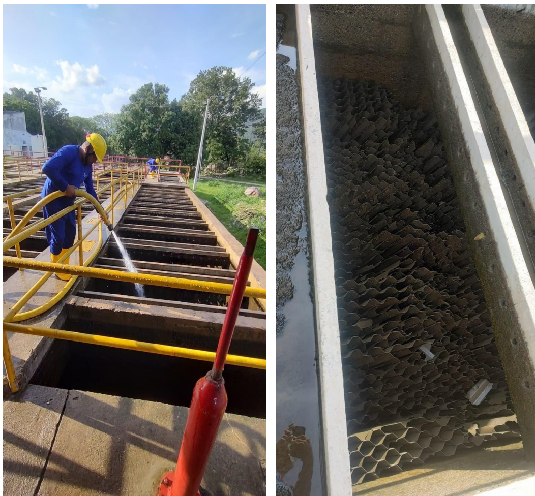
Figura 17. Lavado de sedimentadores
