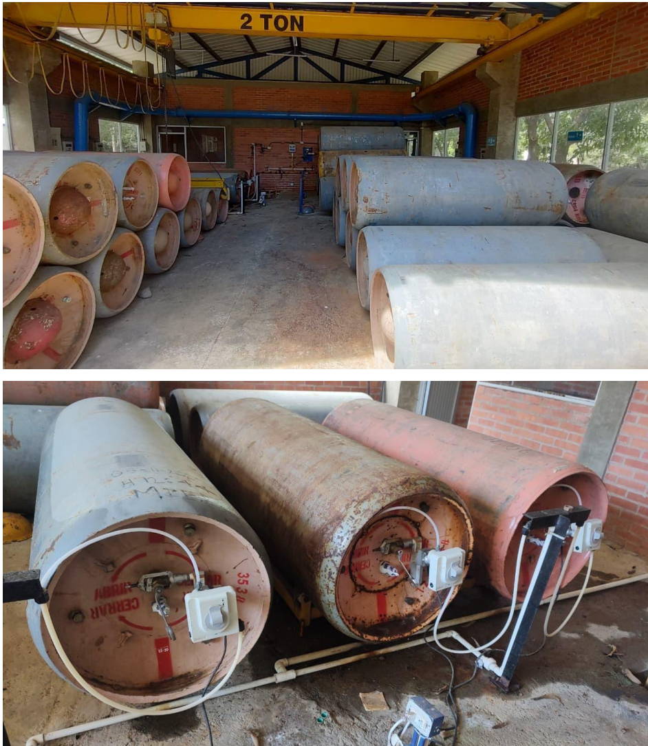
Figura 15. Almacenamiento del cloro gaseoso
