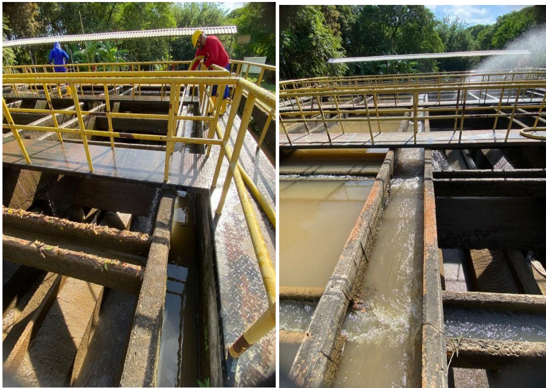
Figura 16. Lavado de desarenadores
