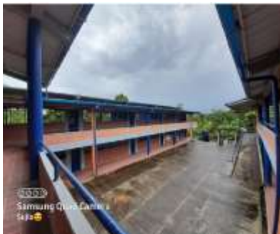
Imagen 3. Estructura interna fondo lateral I. E. Antonio José de Sucre. Fuente las investigadoras 2020.
