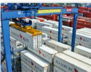
Ilustración 11. Grúa pórtico Puerto de Cartagena
