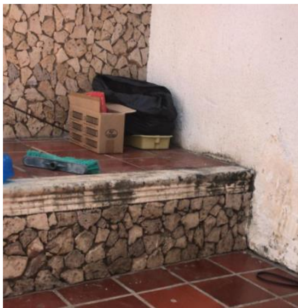
Figura 7. Almacenamiento temporal de residuos.
