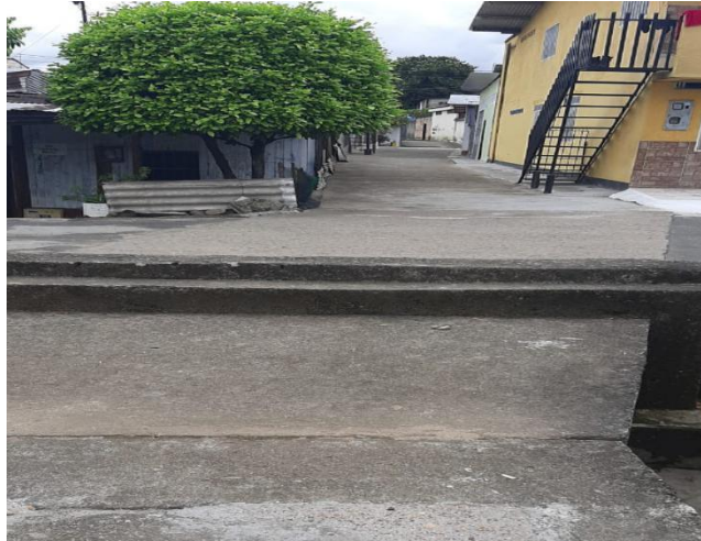
Figura 1. Box Culvert Brisas Bajas. Fuente de elaboración propia
